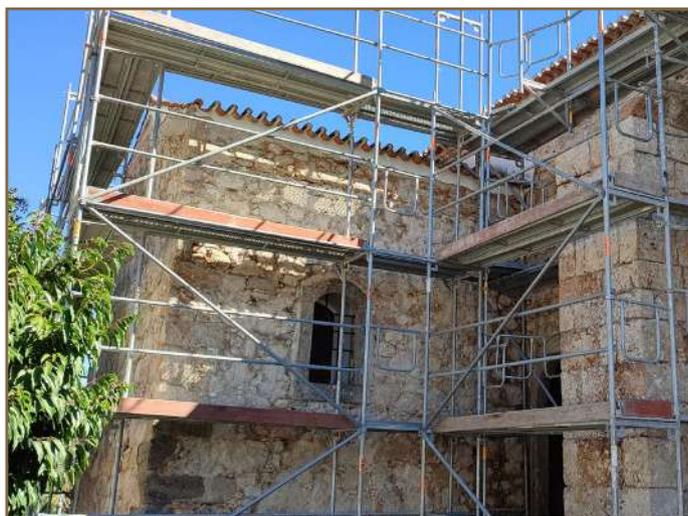
A intervenção no edifício, que decorreu ao longo de todo o ano, fez-se, essencialmente, a nível da cobertura, com a substituição total da mesma; das paredes que foram picadas para remoção do reboco antigo e novamente rebocadas e pintadas; e, também, da limpeza dos arcos e da abóboda da Capela-Mor fazendo reavivar as cores originais.
