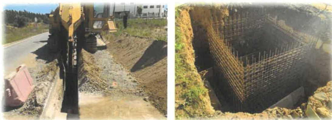
Figura 7 -Evidência Fotográfica da Obra submetida no âmbito do POSEUR-03-2021-001222
