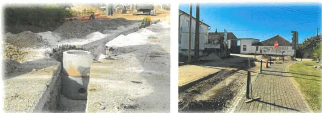
Figura 6 - Evidência Fotográfica da Obra submetida no âmbito do POSEUR-03-2021-001221
