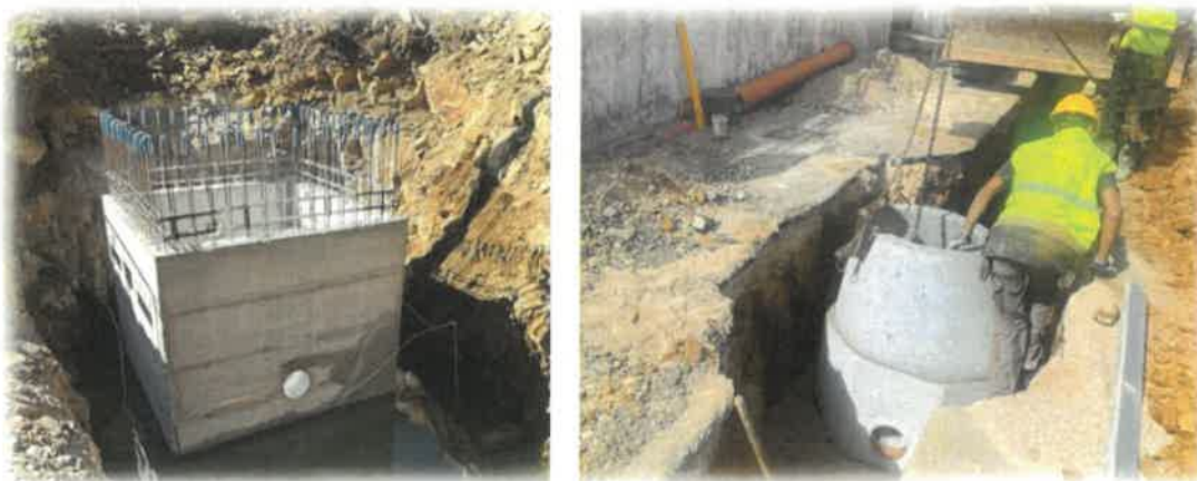
Figura 8 - Evidência Fotográfica da Obra submetida no âmbito do POSEUR-03-2021-001225
