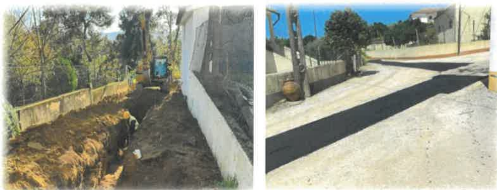
Figura 5 - Evidência Fotográfica da Obra submetida no âmbito do POSEUR-03-2021-001220
