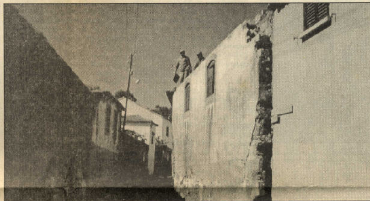
O NÓ-GÓRDIO vai cair; Os pedreiros retiram telhas
