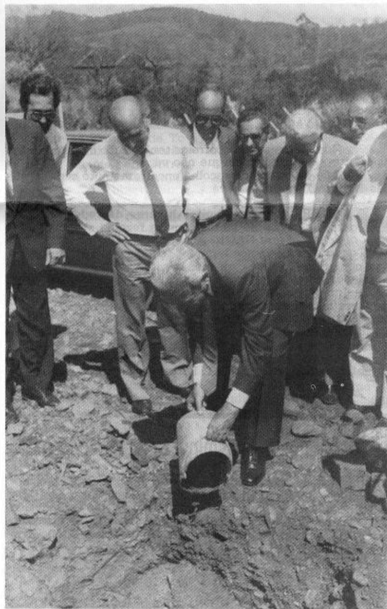
Lançamento da 1.ª pedra, da nova aldeia do Rabigordo, Vila Facaia, Pedrógão Grande, por Dr. Eurico de Melo, Ministro da Administração Interna
