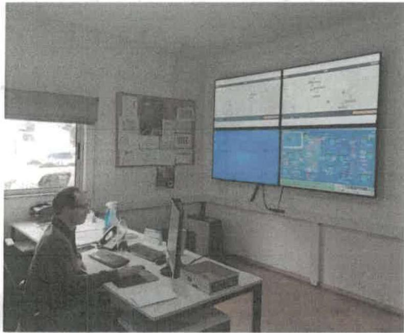
Com o decorrer das obras do projeto da área da Eficiência Hídrica, transversais à APIN, foram instalados ao longo do ano equipamentos para a medição de nível nos reservatórios, de pressão nas redes e de caudal, que permitem, com apoio dos softwares existentes, a análise detalhada dos eventos no sistema de adução e distribuição. Esta monitorização é o contributo basilar para o controlo de perdas, permitindo a identificação precoce de roturas e reconhecimento de zonas críticas.
